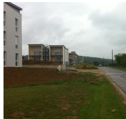
Marnay : Extension en cours rue Gustave Courbet (2013)
